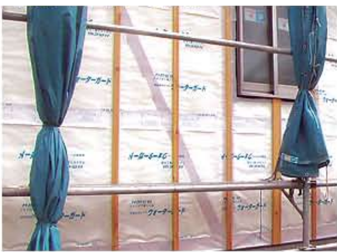
●透湿シートへの施工時の外観
