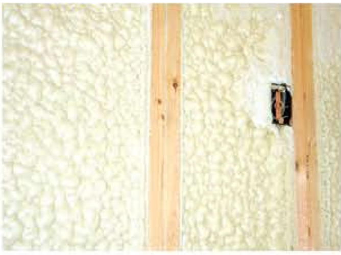
●透湿シートへの施工時の外観
